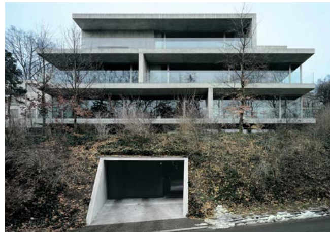
Kerez, Schwartz House Forsterstrasse, Zurich, 2003
