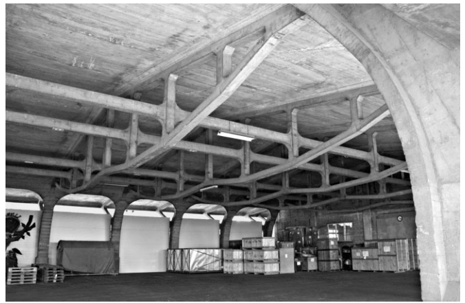
Bild 3 Modelliertes Betontragwerk des Zolllagers Chiasso, ROBERT Maillart, 1924 (Foto: MARIO RINKE) Modeled concrete structure of the customs warehouse Chiasso, ROBERT MAILLART, 1924 (Photo: MARIO RINKE)
