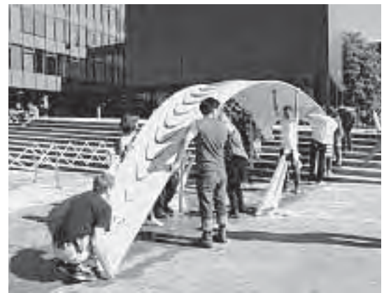
ETH/AA Pavilion Raumbildung durch Biegung Spatial construction by bending
