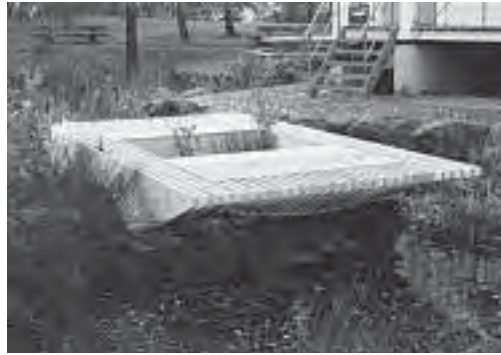
Seminarwoche: Bridging the Gap Experimentelle Holzkonstruktion
